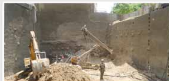
نمونه ای از گودبرداری و تحکیم خاک با استفاده از نیلینگ
