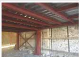
نمونه ای از ایجاد مهاربند فولادی و ایجاد سقف عرشه فولادی
