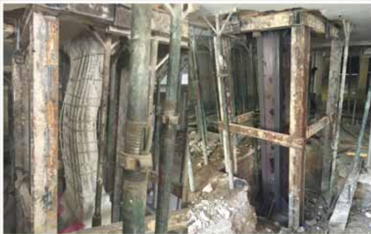
نمونه ای از مقاوم سازی ستون به روش ژاکت فولادی
