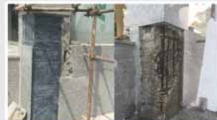
ترمیم بتن و تقویت با (CFRP-SIKA)
