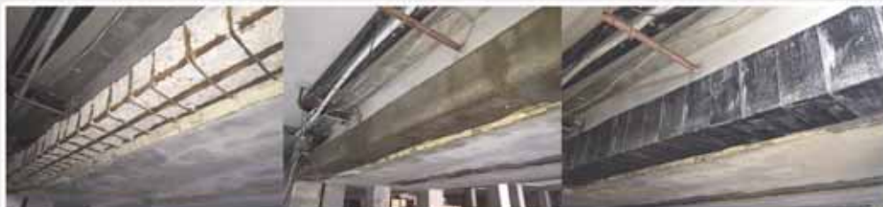
نمونه ای از تخریب و پاکسازی، ترمیم بتن و تقویت با الیاف پلیمری مقاوم شده (CFRP-SIKA)
