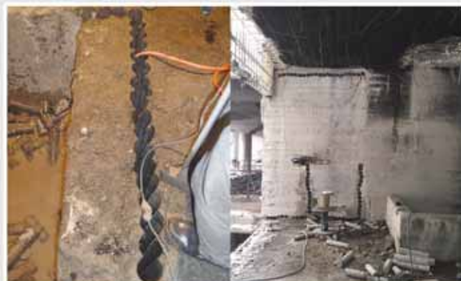
نمونه ای از برش بتن به روش مغزه گیری
