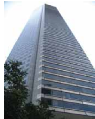
ساختمان کامرس تاور
