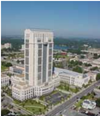
ساختمان کورت هاس
