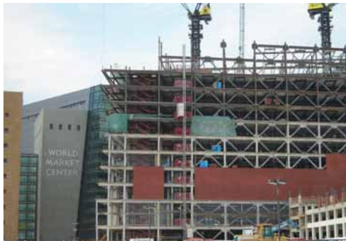
شکل ۶ - استفاده از BRB در سازه فولادی نوساز
